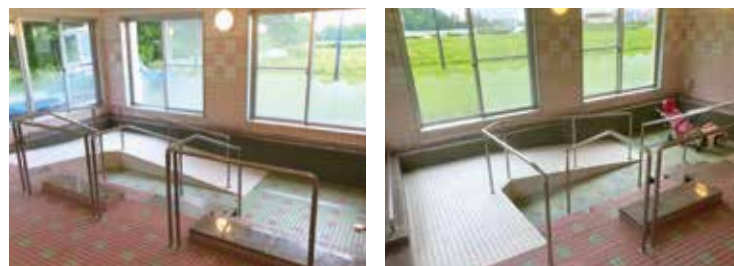
スロープを設置・改修した一般浴槽
